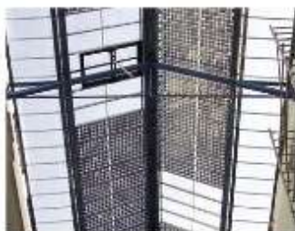
Les capteurs photovoltaïques sont intégrés à la verrière de la galerie de distribution d'une résidence HLM. L'île d'Abeau (Savoie) © Photowatt
