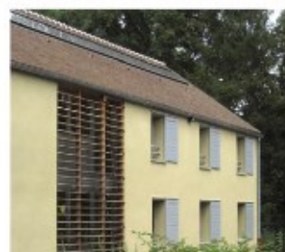
Un ensemble de capteurs thermiques souligne le faîtage de la toiture. Centre médicalisé à Bullion (Yvelines). Cabinet Méandre, architectes © PNR Haute Vallée de Chevreuse
