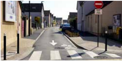
● RUE GAMBETTA La requalification complète est terminée.
